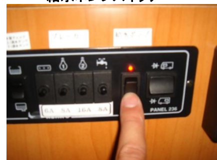
給水ポンプスイッチ
